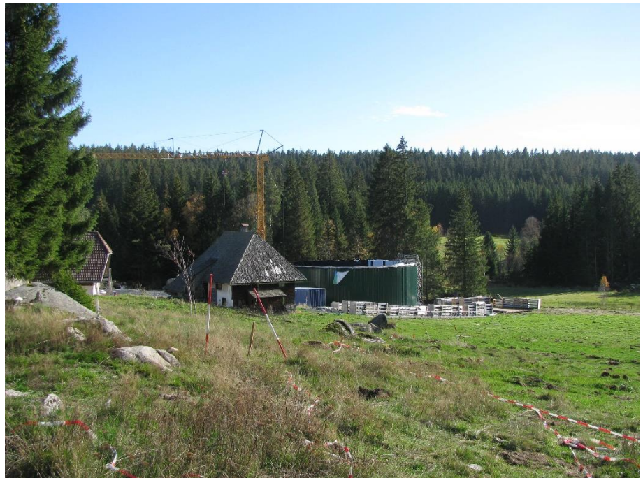
Abb. 11: Blick nach Südosten, Wärmespeicher im Bau. Im Vordergrund ausgesteckt der Bereich, auf dem die PV-Kollektoren errichtet werden sollen (Foto: faktorgruen 27.10.2022)
