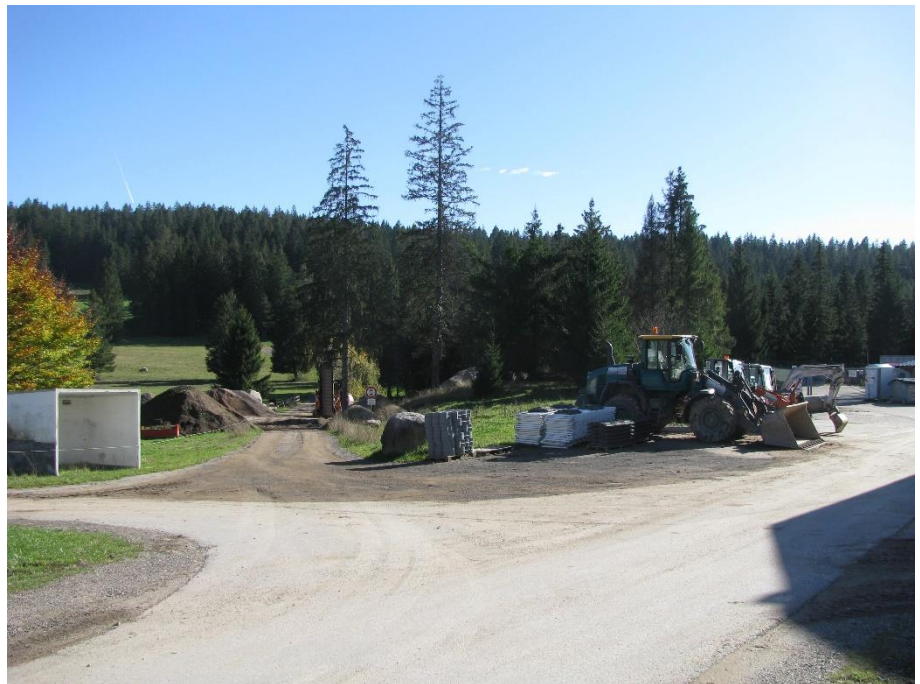
Abb. 6: Zufahrt zum Baggerbetrieb, Wertstoffhof sowie über die Gutach, Blick nach Osten (Foto: faktorgruen 27.10.2022)
